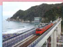
余部鉄橋 (あまるべてっきょう) H29年に、空の駅エレベーター(余部クリスタルタワー)が完成。 休暇村から車で約30分
