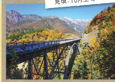
2 北アルプス大橋 見頃: 10月上旬~下旬
