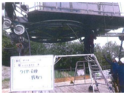
網張第2リフトA線制御装置更新工事、ロープ更新工事
