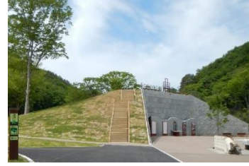
がれきを使い造成した「展望の丘」から海を望むと目線が津波と同じ高さになります
