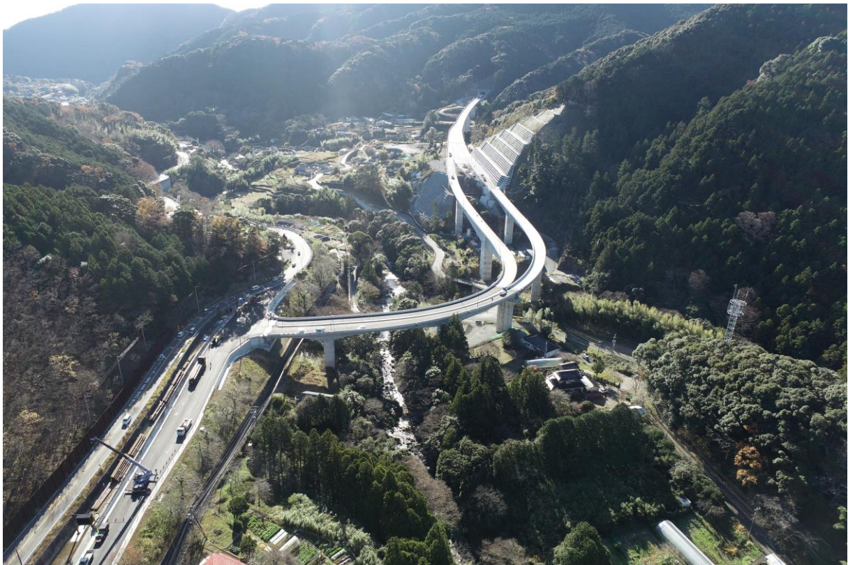
伊豆に新しい道路ができました ※河津七滝 I C 付近（2022年12月撮影）
