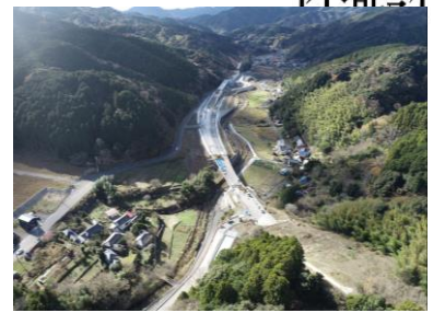
河津逆川橋 ※2022年12月撮影
